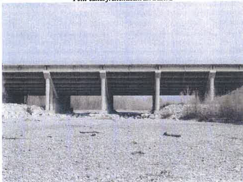
Photo n°5 Pont-canal franchissant LA BLEONE
