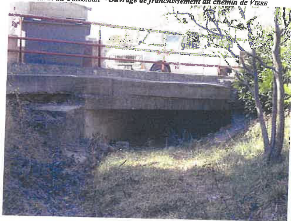
Ravin du TOLLONNET – Ouvrage de franchissement du chemin de VIERE
