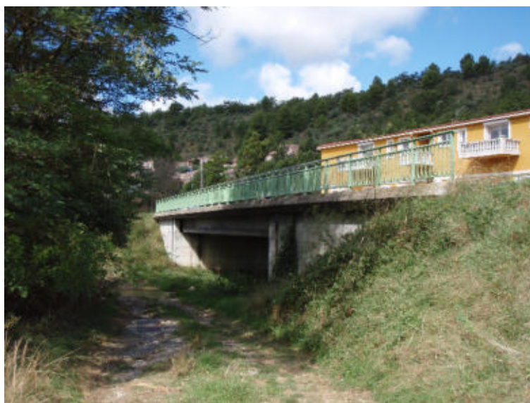
Photo n° 1 - Vue du pont de la CD 952
