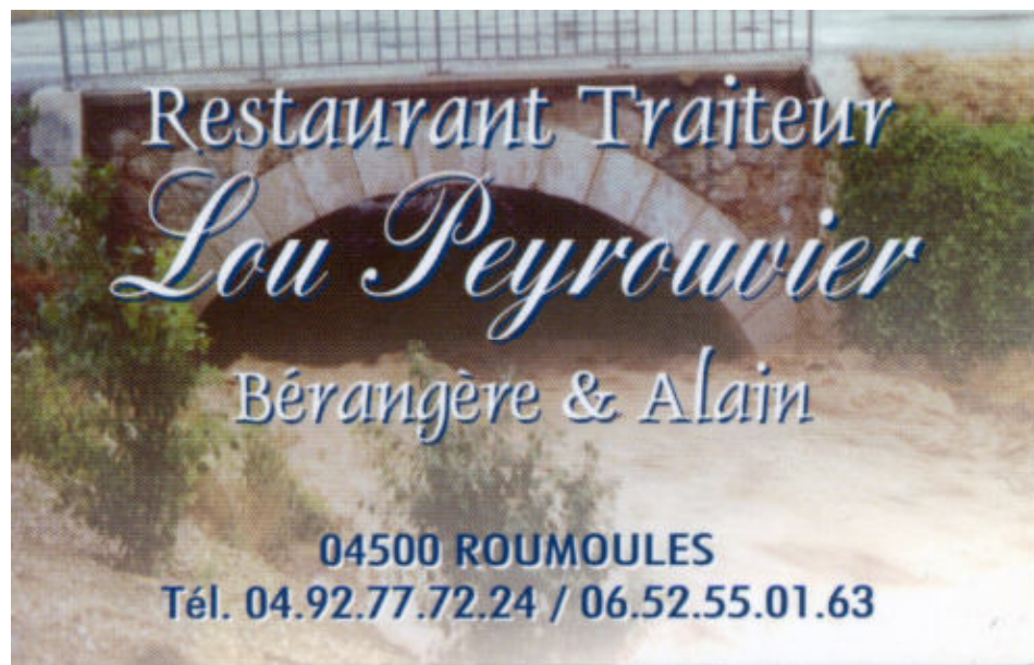
Photo n° 8 - Vue du pont de Peyrouvier lors de la crue du 6 juillet 2010
