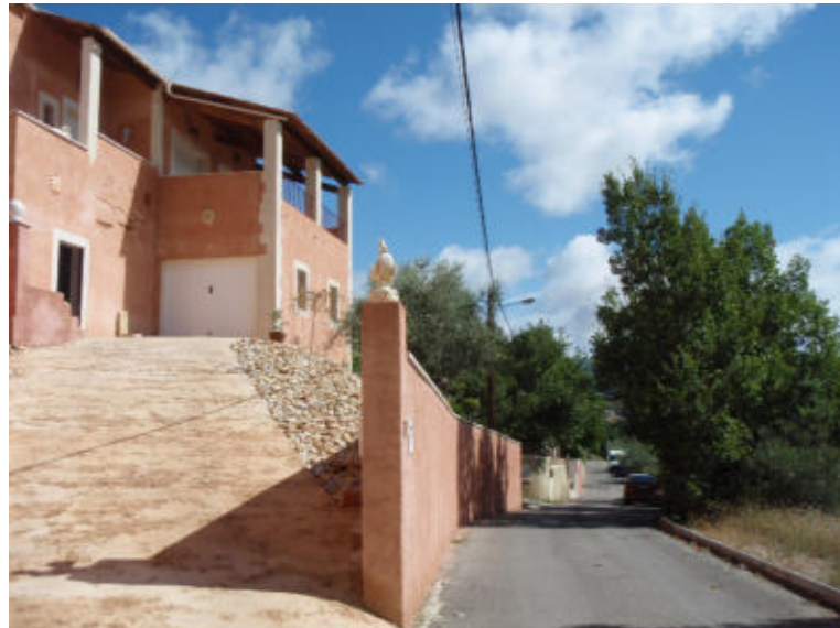
Photo n° 17 - Bâtiments dépourvus de gouttière dans le lotissement des Adrechs
