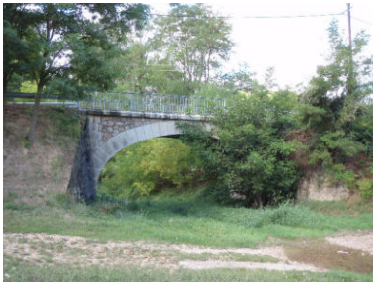
Photo n° 2 - Vue du pont de la Garenne
