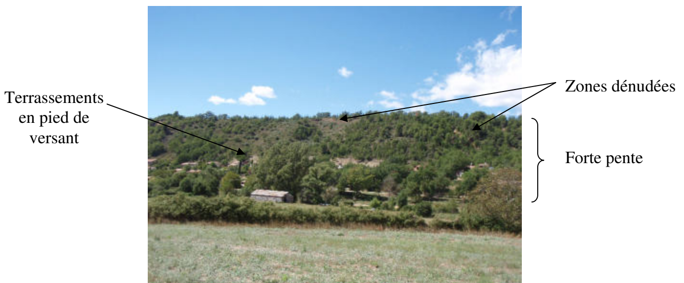
Photo n° 6 : vue de la colline des Adrechs Zone érodée naturelle ou liée à l'action humaine
