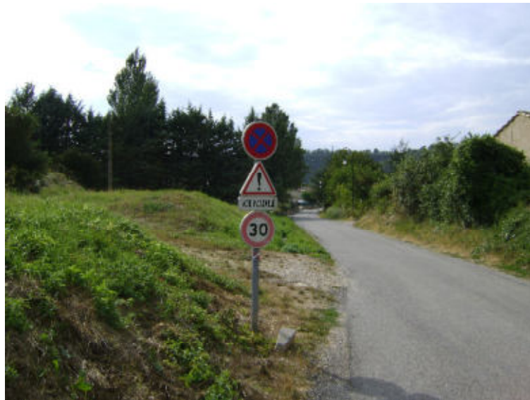
Photo n° 11 - Panneau voie inondable rue Grande
