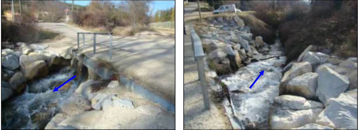
Figure 45 : Gué sur l'Auvestre dans le quartier de St-Sébastien [Source : IMS RN ]
