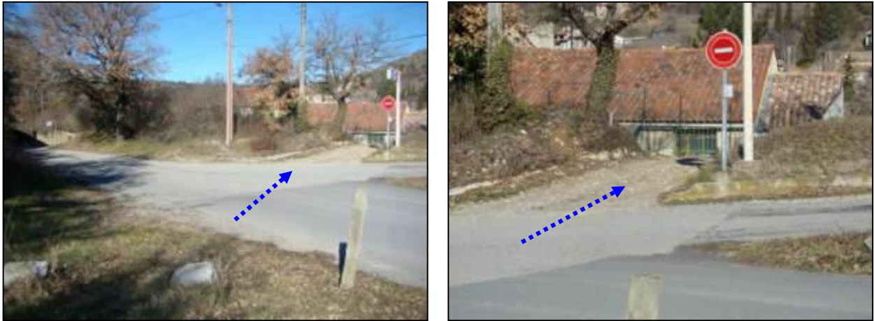
Figure 49 : Construction en bordure immédiate de l'Auvestre en aval de la RD 953 [Source : IMS RN ]
