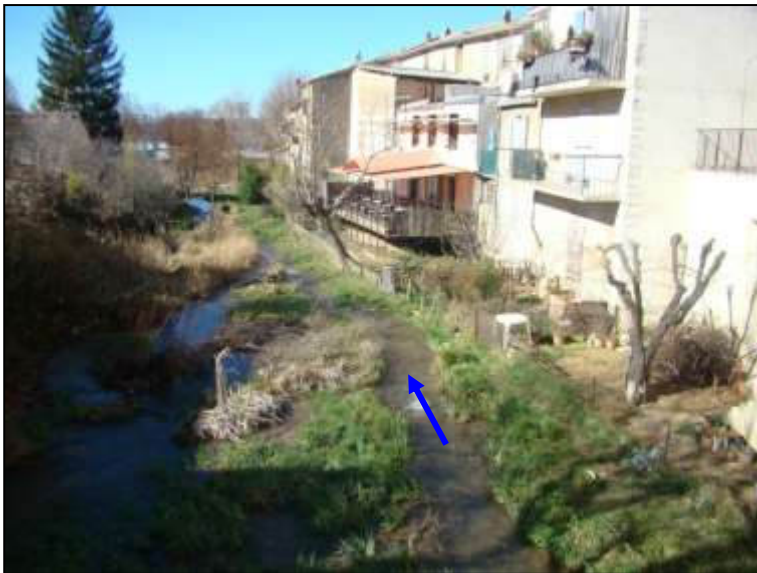
Figure 43 : Constructions dans le lit du Colostre en aval du pont Jacquet [Source : IMS RN ]
