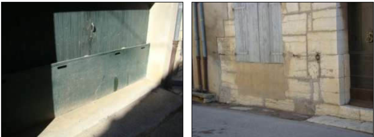
Figure 50 : Batardeau (à gauche) et réhaussement (à droite) en bordure de la RD 11 au niveau du pont Jacquet [Source : IMS RN ]
