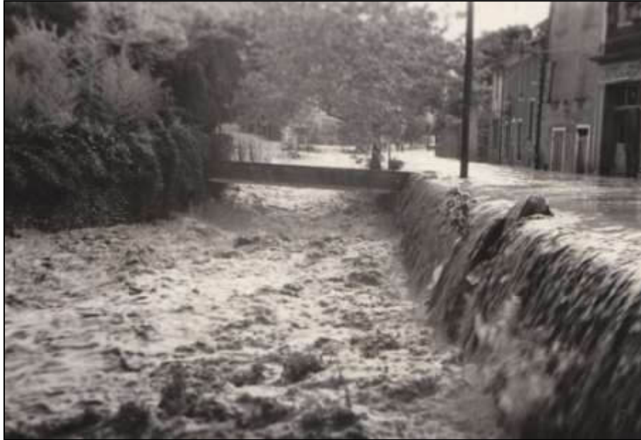
Figure 14 : Ravin de Tartavel au niveau du village d'ALLEMAGNE-EN-PROVENCE lors de la crue du 31 juillet 1960 [Source : Archives communales]
