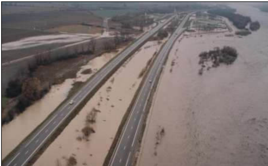
Figure 13 : La Durance au niveau de l'aire de MANOSQUE lors de la crue du 7 janvier 1994 [Source : DDT 04]
