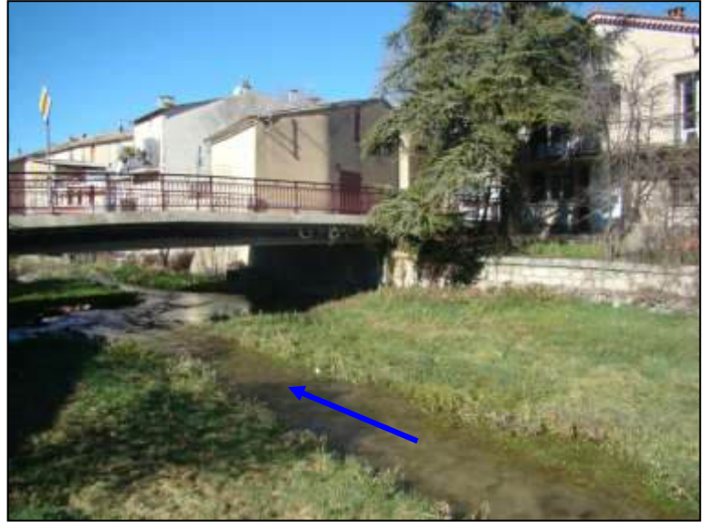
Figure 42 : Constructions à proximité du Colostre en amont du pont Jacquet [Source : IMS RN ]
