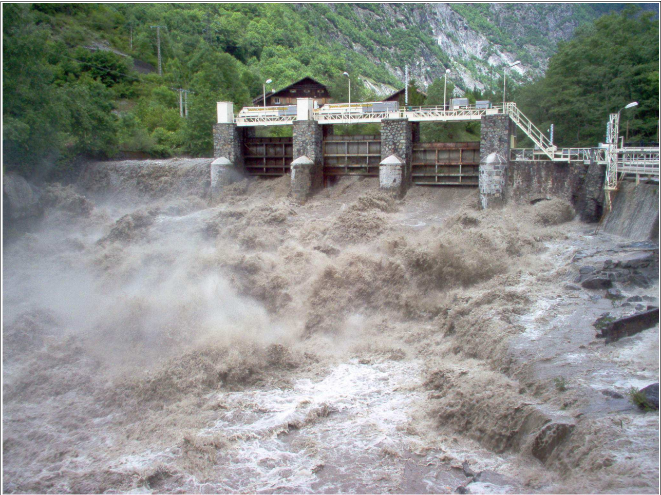
Photo 22 : Barrage de Séchilienne (Pierre Ebeyse) lors de la crue de la Romanche en Mai 2008. Syndicat Mixte des Bassins Hydrauliques de l'Isère.
