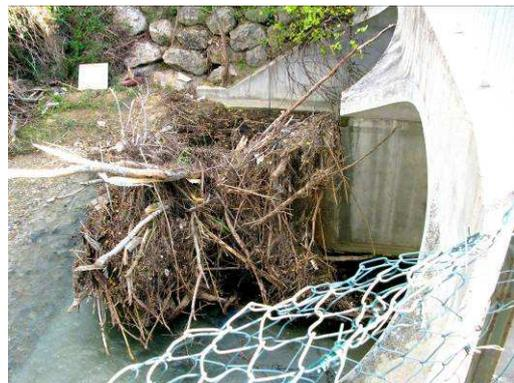
*Photos 108 : Accès Carrefour Trans en Provence – 2 arches circulaires accumulant les embâcles*
