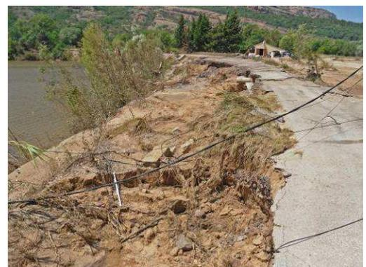
*Photos 25 : L'Argens à Roquebrune Dégradation de la chaussée à l'amont du lac de l'Aréna - Post crue*
