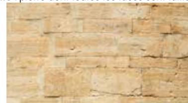
Fig. 16. Mur en pierres de taille Source : A4PLUSA
