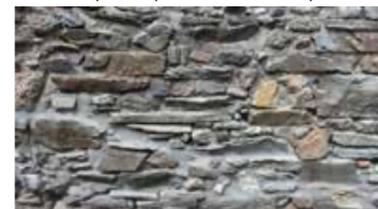
Fig. 15. Mur en moellons Source : A4PLUSA
