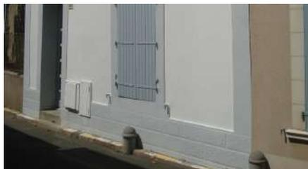
Fig. 63. Soubassement en mortier
