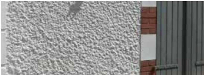
Fig. 8. Enduit à la tyrolienne Source : A4PLUSA
