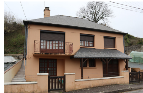
Rue du Moulin à Tan
