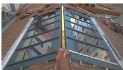
Verrières, en verre et métal, implantées aux faitages de toitures
