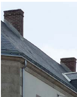
Couronnement en tuiles creuses
