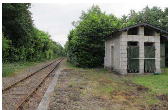
Abri en bordure de voies - 2013 (source : AVAP Les Herbiers - 2014)
