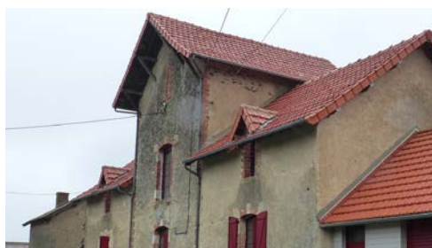
Couverture en tuiles plates losangées sur bâtiment agricole début XX ème .
