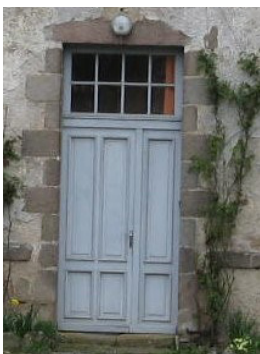
Porte en bois plein et imposte vitrée (cliché Anne Boissay - architecte)
