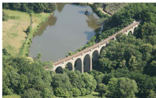
Viaduc de Coutigny (sources : Mairie des Herbières)
