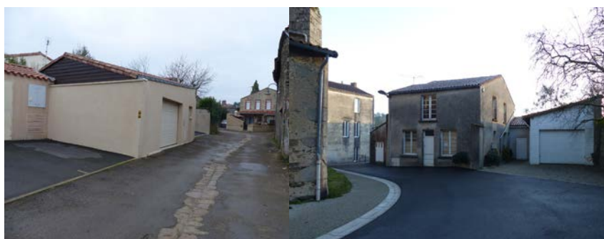
Des garages récents qui ne s'intègrent pas au tissu ancien (gabarit et matériaux employés)
