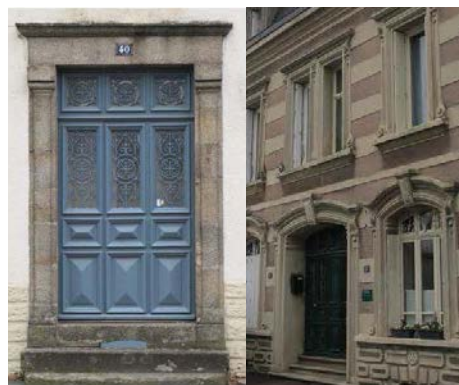
Encadrements en pierre (granite et calcaire)
