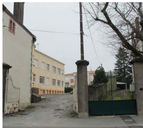
30 - 40 rue du Brandon - 2013 (source : AVAP Les Herbiers - 2014)
