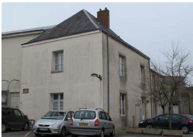
Le grand logis, rue Neuve - 2013 (source : AVAP Les Herbiers - 2014)
