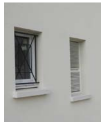
Pompe à chaleur dissimulée derrière une grille dans une baie de la façade
