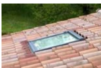
Châssis de toit intégré dans une toiture en tuile
