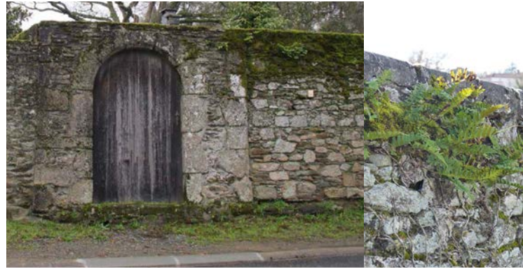
Murs hauts en pierre
