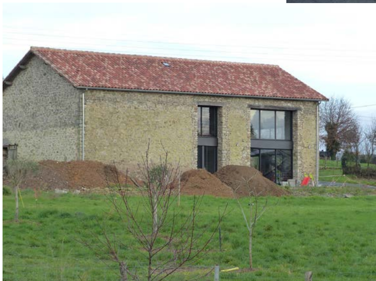
Réalisation de percements et de menuiseries sur mesure, dans le respect des proportions des granges anciennes
