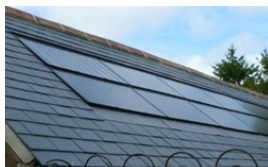
Panneaux sur couverture ardoises
