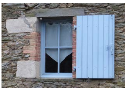
Petite fenêtre traditionnelle à 1 vantail et 4 carreaux en bois avec petits bois extérieurs (cliché Anne Boissay - architecte)
