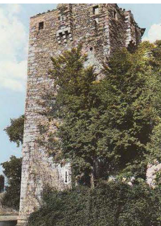
Après 1964 (toiture effondrée) (source : AVAP Les Herbiers - 2014)
