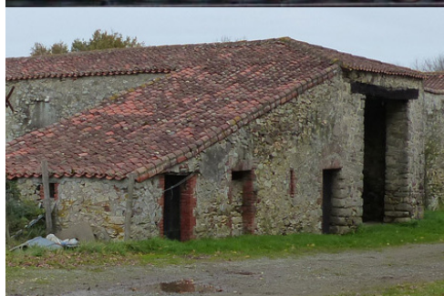
Couverture traditionnelle en tuiles « tige de botte »
