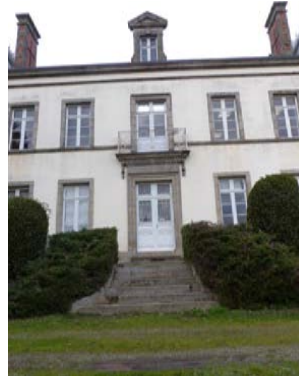
Façade ancienne ordonnancée (cliché Anne Boissay - architecte)
