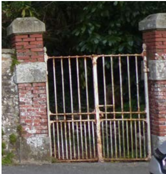
Ancien portail en ferronnerie (cliché Anne Boissay - architecte)
