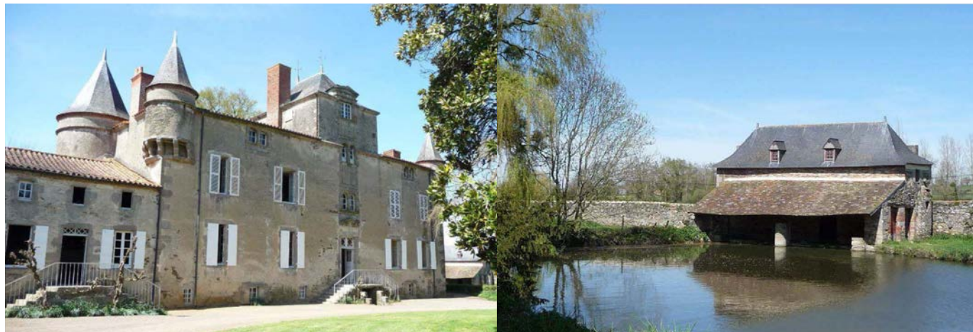
Corps d'habitation principal - 2013 (source : AVAP Les Herbiers - 2014)
