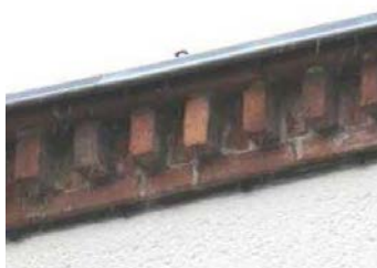
Corniche en briques à modillons
