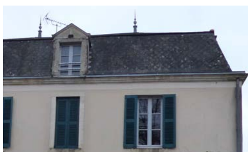
Couverture traditionnelle en tuiles « tige de botte »
