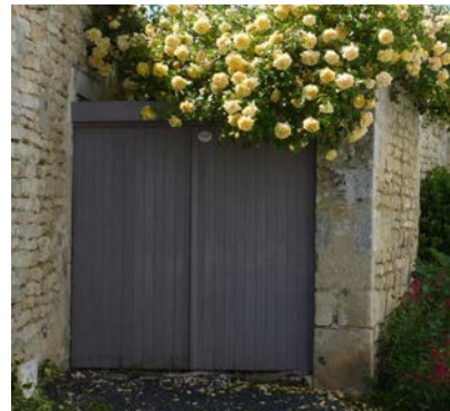
Portail en bois à lames jointives
