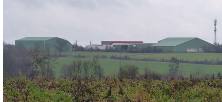
Des bâtiments agricoles très présents dans le paysage
