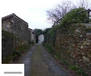
Mur de soutènement, rempart, mur de clôture
