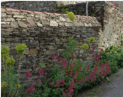
Murs hauts couronnés de tuiles tiges de botte (cliché Anne Boissay - architecte)
