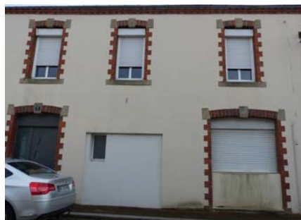
Menuiseries standardisées PVC ; ouvertures et modifications de baies
