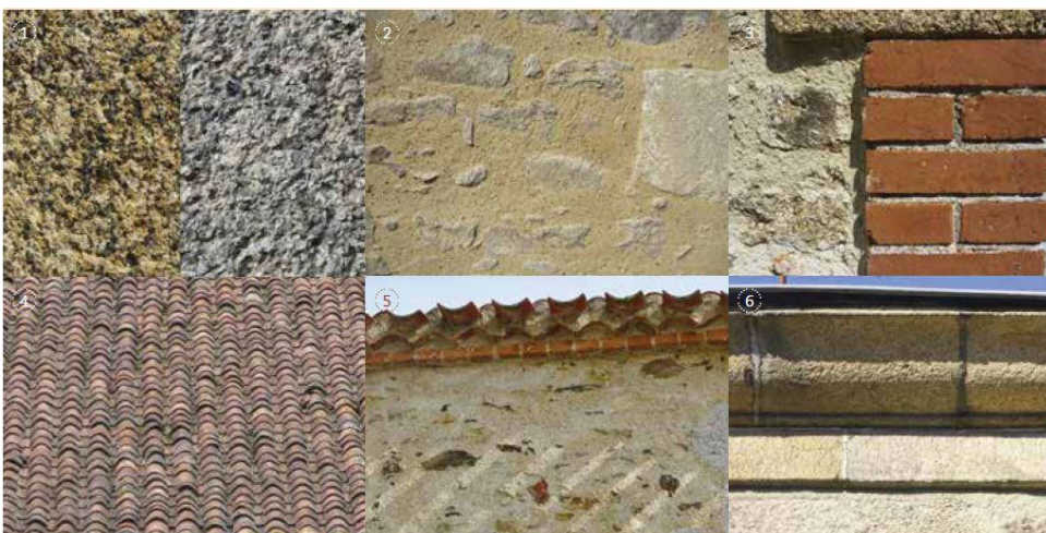
Granites, enduit à la chaux sur mur en pierre, brique, tuile tige de botte, génoise, corniche en granite. Les matériaux traditionnels du bocage vendéen (source : CAUE 85 – « Bien construire entre Sèvre et Maine »)
