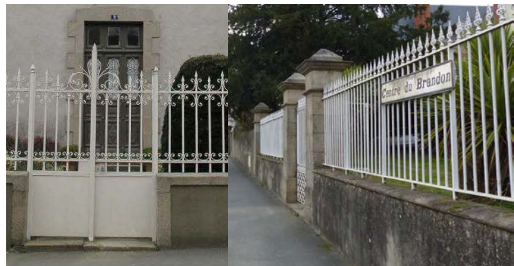
Murs bahut surmontés d'une grille
