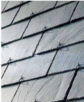
rang de doublis Pose clouée sur un voligeage
