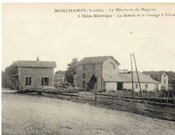
Usine Deverteuil à Mouchamps (Source : archives départementales)
