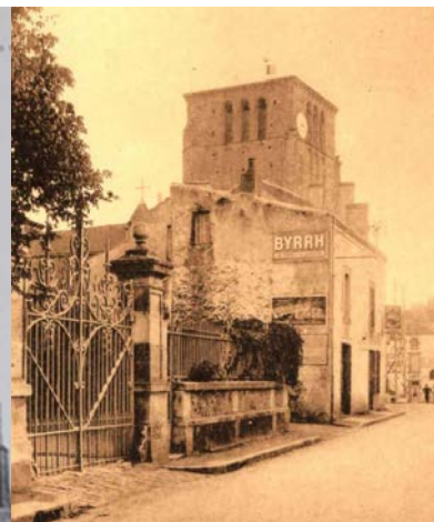
Eglise Saint-Pierre (Source : archives départementales)
