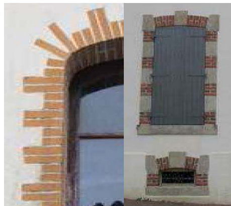
Encadrements en briques et alternance brique et pierre
