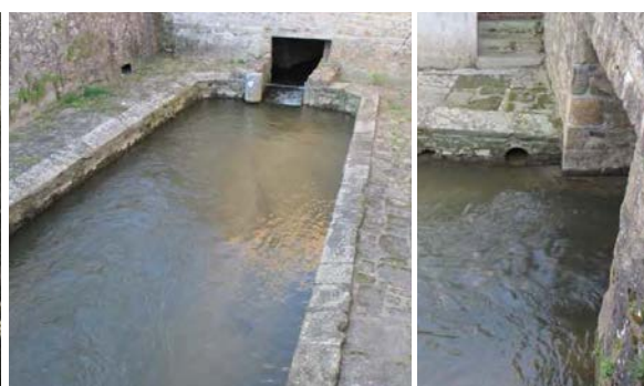
Le lavoir du pont de la ville - 2013 (source : AVAP Les Herbiers - 2014)
