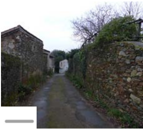
Mur de soutènement, rempart, mur de clôture
