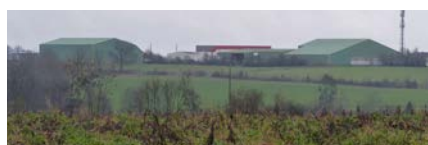
Des bâtiments agricoles très présents dans le paysage
