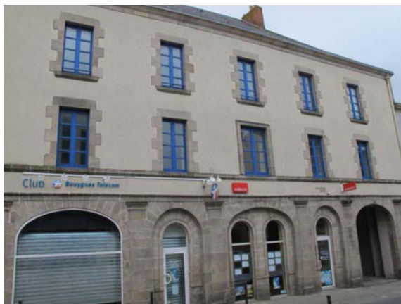
L'ancienne gendarmerie, rue de l'Église - 2013 (source : AVAP Les Herbiers - 2014)
