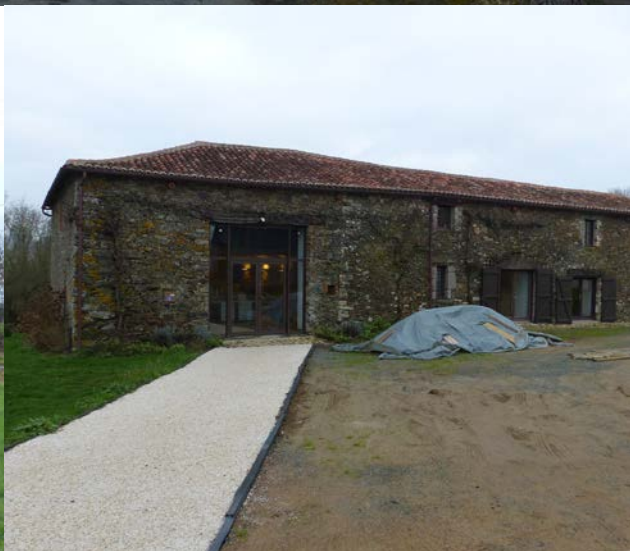
Réalisation de percements et de menuiseries sur mesure, dans le respect des proportions des granges anciennes
