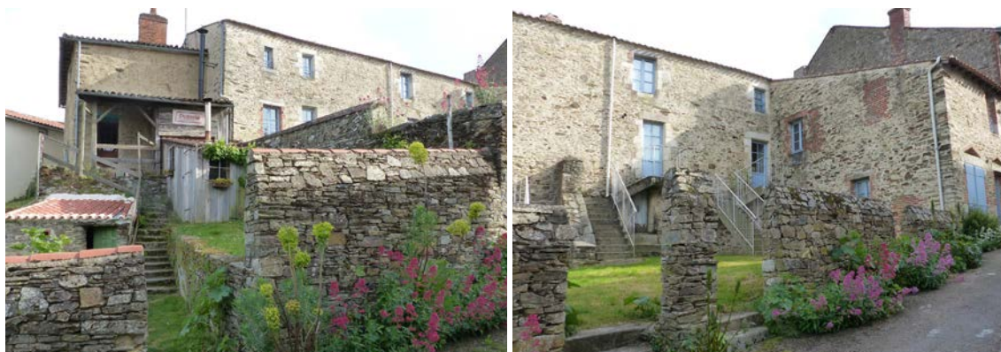
5 et 7 rue du Vieux Château - 2019
