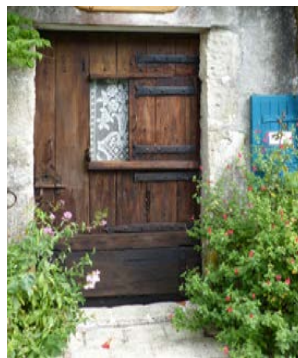
Coffrets dissimulés par un portillon en bois
