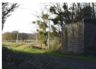
Base d'un pont de voie ferrée, Mouchamps - 2019
