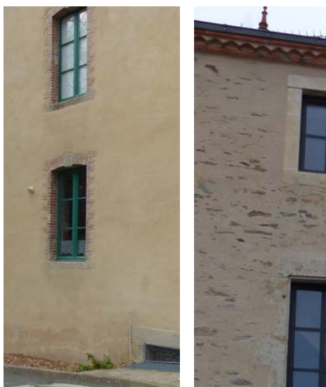
Façades de moellons recouverts d'un enduit chaux-sable. Enduit couvrant et encadrement en briques ; enduit beurré et encadrement en pierre de taille. (cliché Anne Boissay - architecte)
