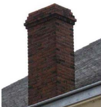
Cheminée en briques
