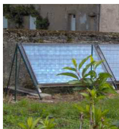
Panneaux au sol adossés à un mur de clôture
