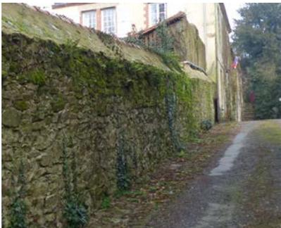
Les murs hauts sont constitués de moellons jointoyés au mortier de chaux.
