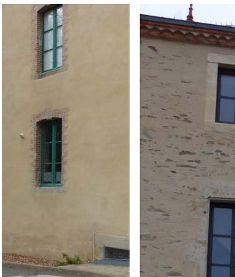
Façades de moellons recouverts d'un enduit chaux-sable.
