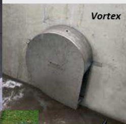
Système de cloison avec orifice
