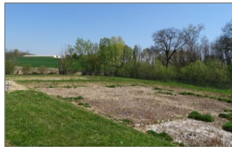
Station de traitement des eaux usées d'Illiat au Nord des Janeins
