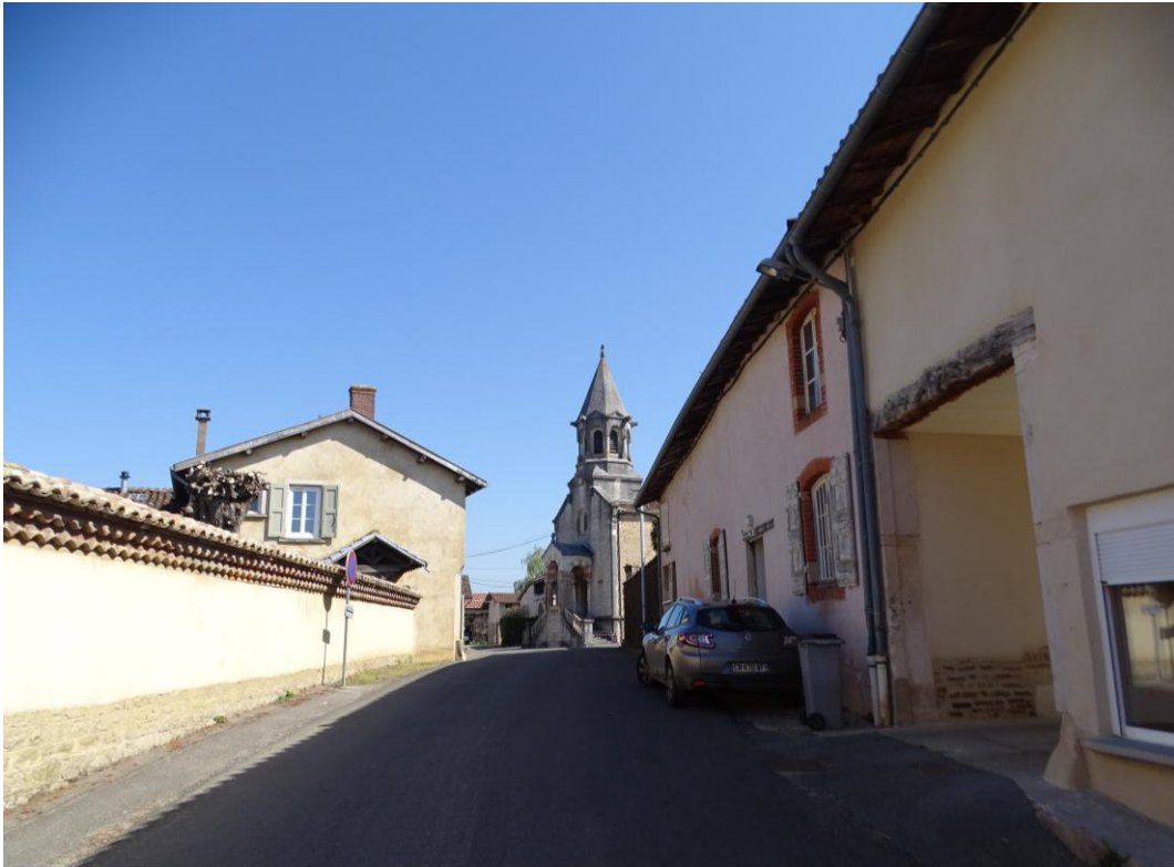
Encadrements de fenêtre en brique
