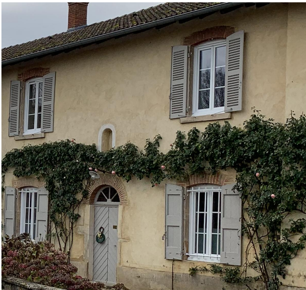
Linteaux cintrés en brique
