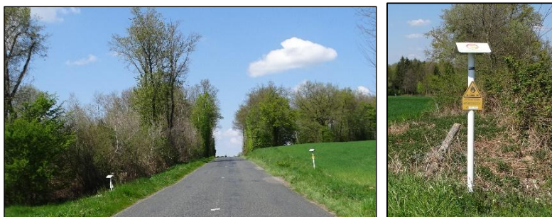
Bornes localisant l'oléoduc sur la traversée de la RD 66
