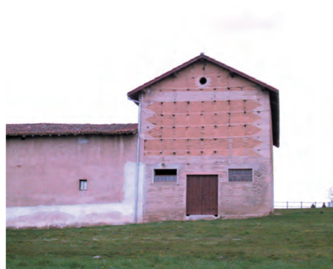
Polleins, bâtiment en pisé
