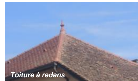
Toiture à redans
