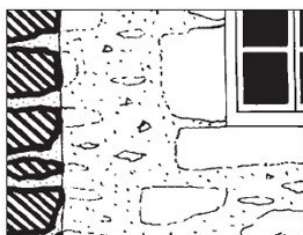
Joints à pierre vue
