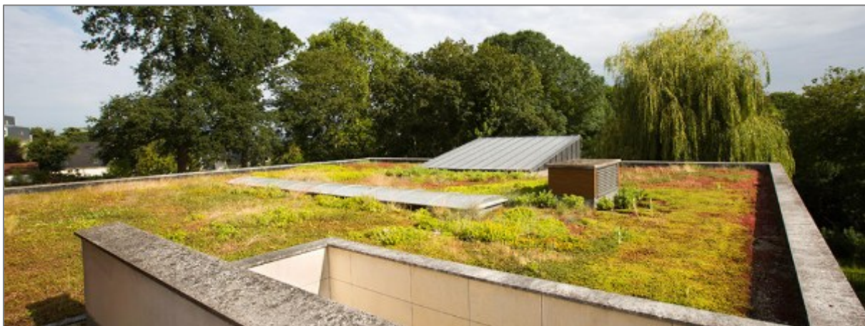
Acrotère sur un toit-terrasse végétalisé
