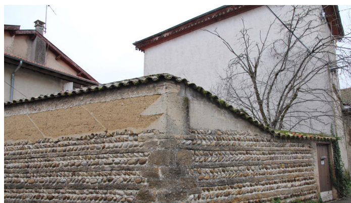
Murs de clôture en galets et pisé reliant deux constructions
