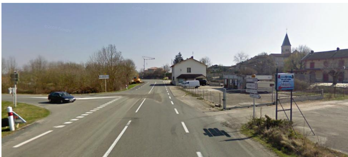
RD 1083 à hauteur de la gare de Saint Paul de Varax, voie large, non sécurisée et où la vitesse est élevée
