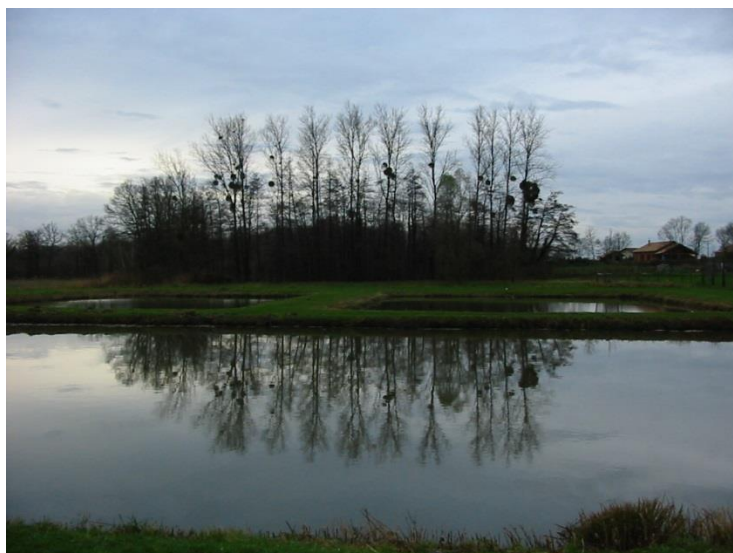
Figure 8 : Photo de la station de traitement de la commune de Versailles
