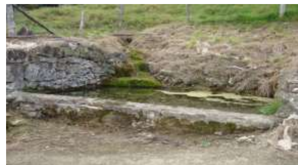
Lavoir Rue de la Montagne
