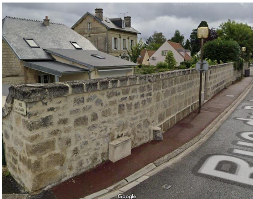
7 – Rue du point du jour
