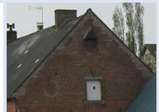
Pignon couvert s'arrêtant au nu du mur
