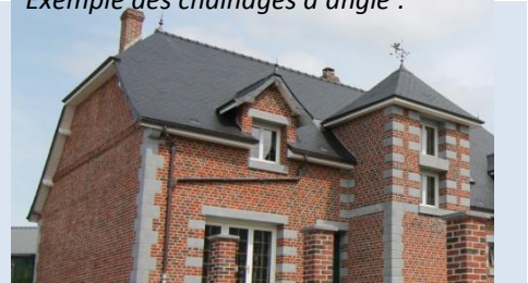
Exemple des chaînages d'angle :
