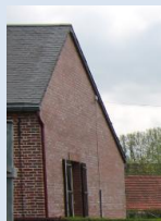
Pignon légèrement couvert et pratiquement au nu du mur
