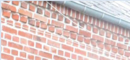
Exemple de corniche créant un léger relief
