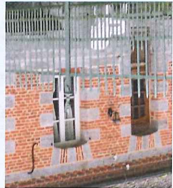
Exemple de corniche créant un léger relief, ou différence entre la brique et la pierre bleue
