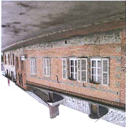
Élévation en brique, Encadrement des fenêtres en pierre bleue et brique, soubassement en pierre bleue et bandeau horizontal en pierre bleue.
