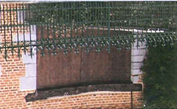
Exemple de corniche créant un léger relief, ou différence entre la brique et la pierre bleue
