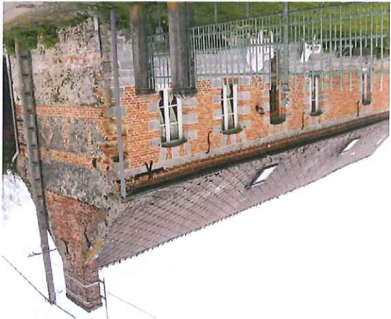
Élévation en brique, Encadrement des fenêtres en pierre bleue et brique, soubassement en pierre bleue et bandeau horizontal en pierre bleue.
