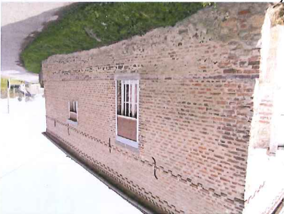
Élévation en brique, Encadrement des fenêtres en pierre bleue et brique, soubassement en pierre bleue et bandeau horizontal en pierre bleue.
