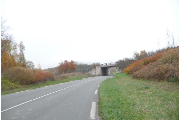
Entrée III : La troisième entrée passe sous la RN2 en léger retrait du village. Il s'agit d'un passage à mettre en valeur pour « marquer » l'entrée dans une nouvelle commune.
