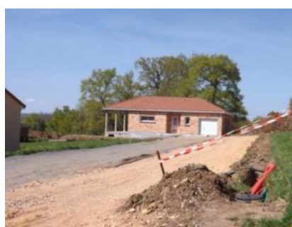
Maison en construction, les Vialattes
