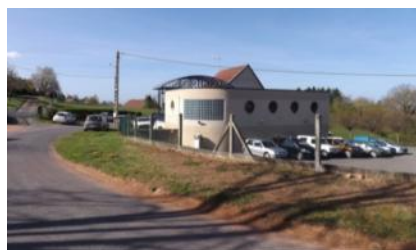
SIVOM Vallée du Sichon, route de Mariol
