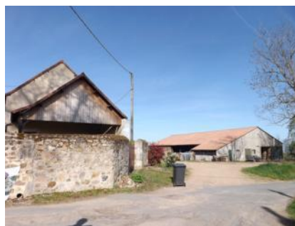
Exploitation agricole, rue du stade
