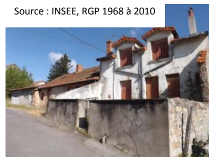
Logement a priori vacant, rue des Merciers
