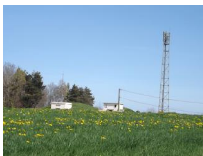
Le réservoir d'eau, près du hameau des Bodiments
