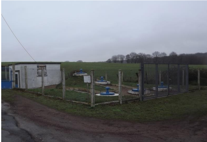
Photographie 25 : Captage d'eau des Tardes
