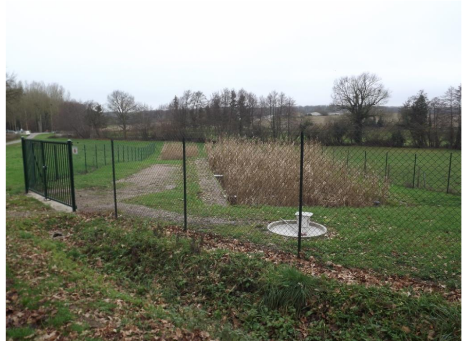
Photographie 26 : La station d'épuration
