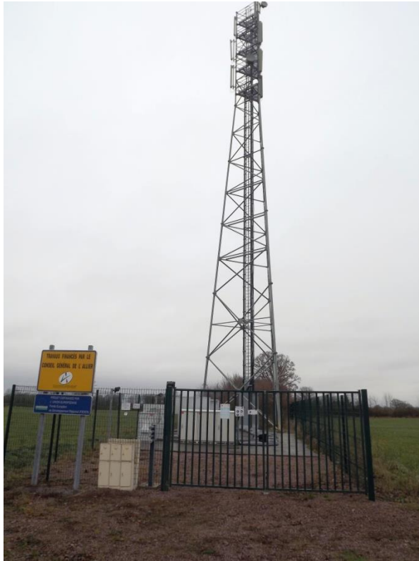
Photographie 27 : L'antenne relais se trouvant sur la commune de Valigny
