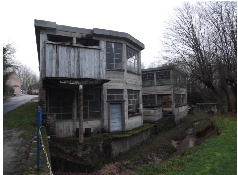
Photographie 14 : L'ancienne fabrique de pièces métalliques
