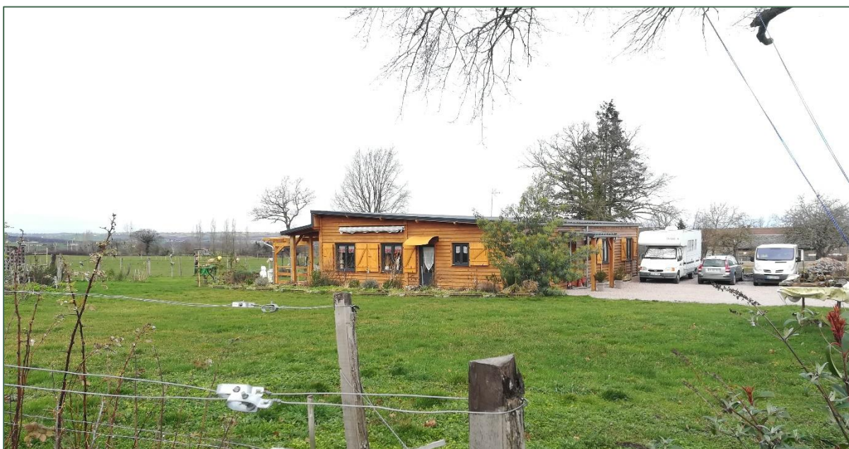
Pavillon en dent creuse du bourg, photo CDHU
