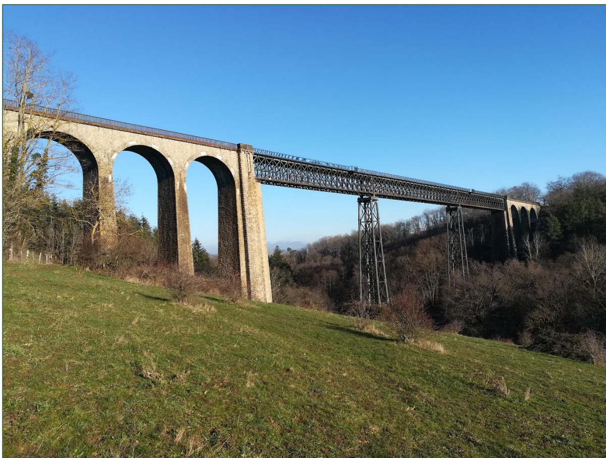
Viaduc du Bellon depuis Louroux-de-Bouble
