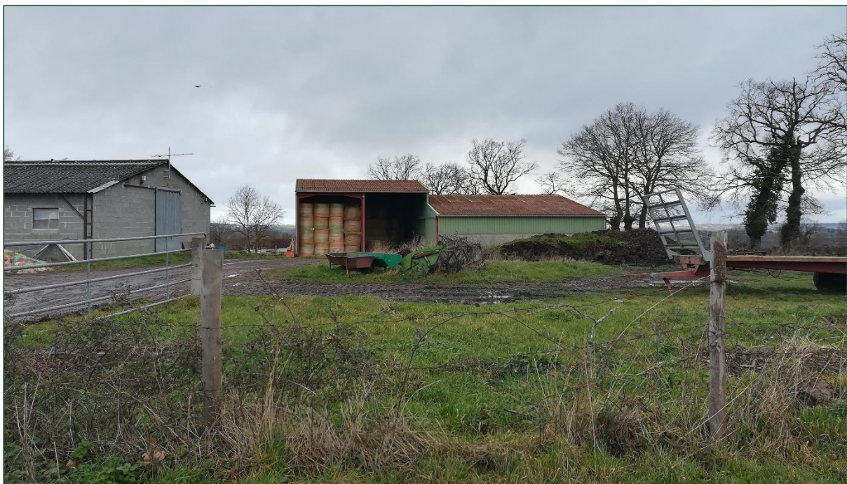
Bâtiment d'exploitation à l'est du bourg, photo CDHU
