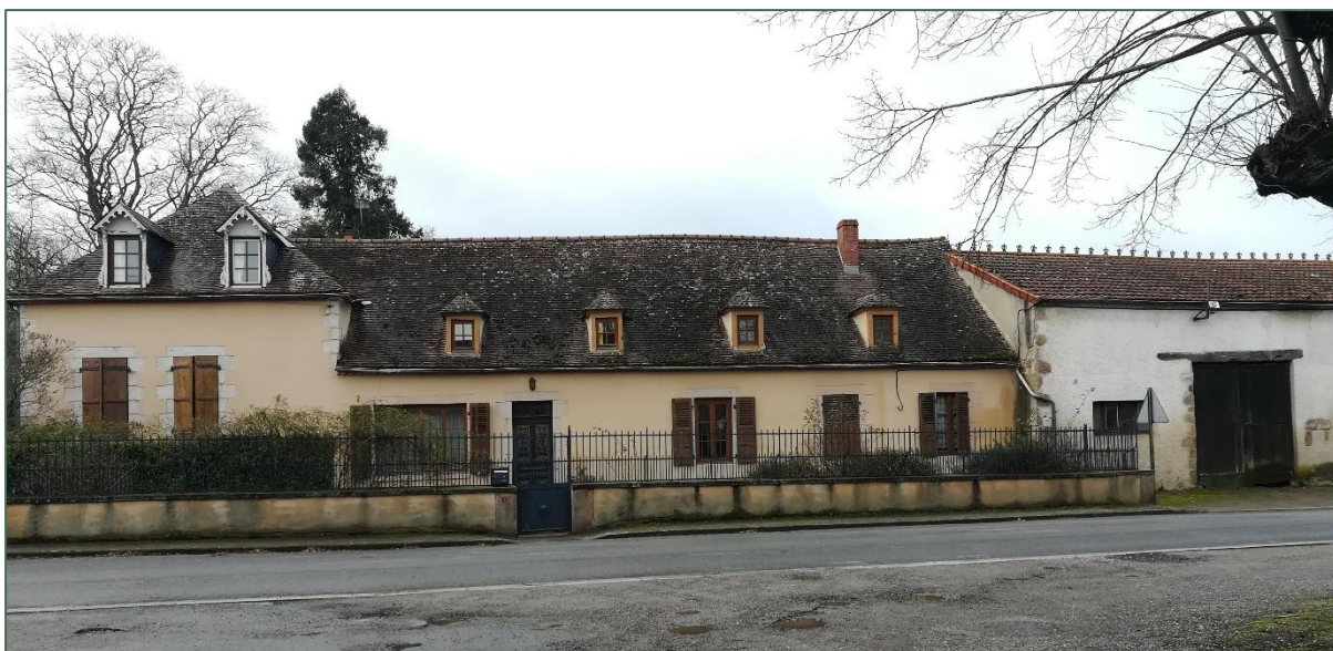
Longère en retrait de la voirie, photo CDHU
