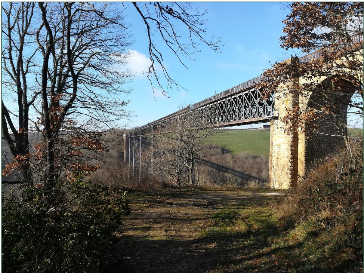
Viaduc de la Bouble depuis la commune d'Échassière, photo CDHU
