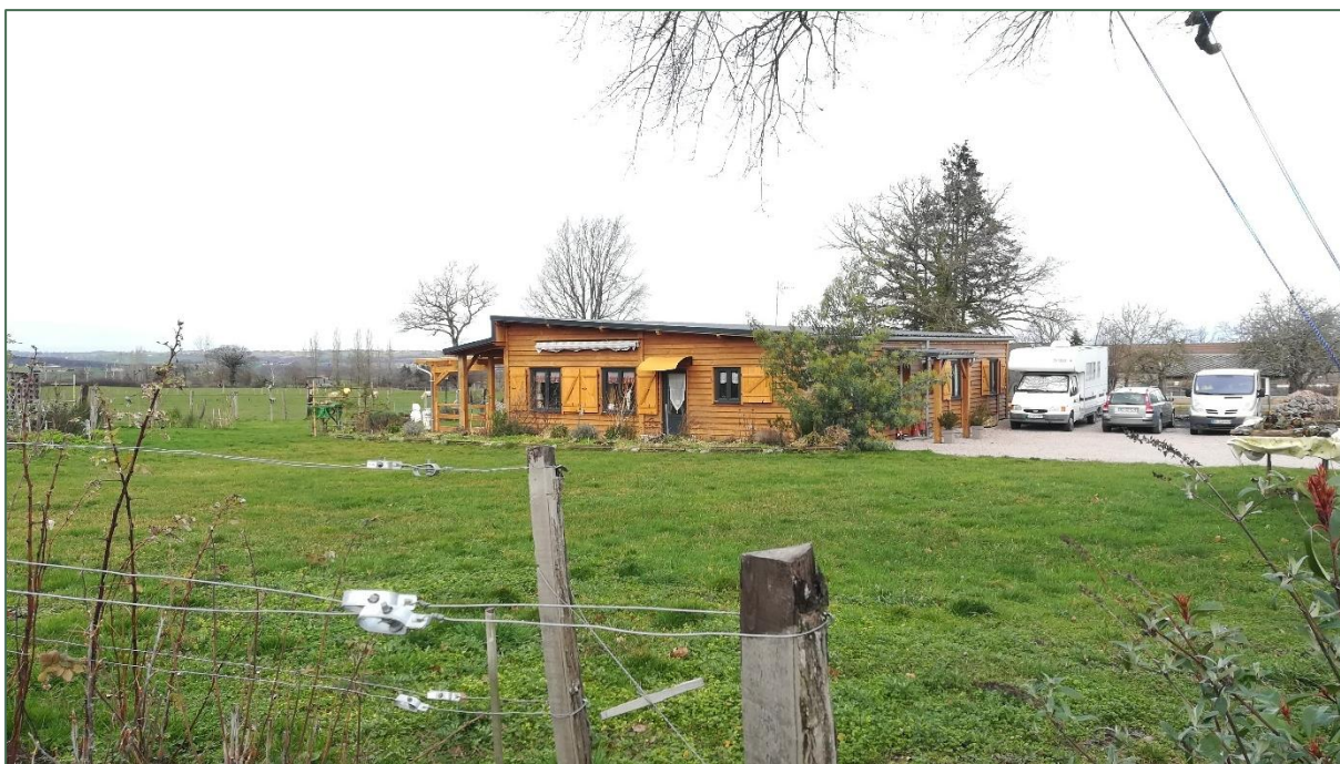
Pavillon implanté en milieu de parcelle, photo CDHU
