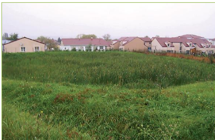
Bassin de rétention à Cusset (source : plaquette « Intégrer la gestion des eaux pluviales dans un projet d'aménagement » de Vichy)
