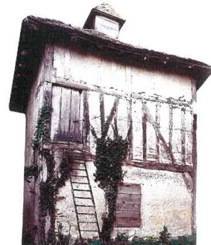
Caffière, maison noble disparue Il ne reste de la maison qu'un pigeonnier à colombage, de la fin du Moyen-Age. Un épi à fleur de lys orne le faite de la toiture et signe l'appartenance de la maison.
