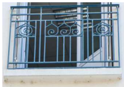
Barre d'appui année 30, scellée en façade, hauteur inférieure à 30cm appui de croisée. Modèle industriel
