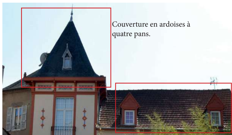
Couverture en tuiles mécaniques à 2 pans.
