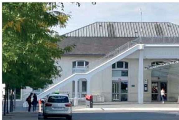
Passerelle devant le bâtiment de la gare
