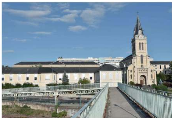
Seconde passerelle au-dessus des voies ferrées
