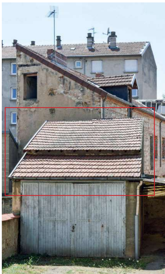
Couverture en tuiles mécaniques en appentis
