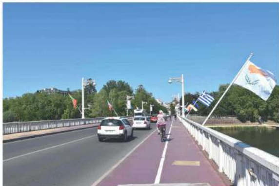
Pont de Bellerive : des voies réservées aux piétons et cycles
