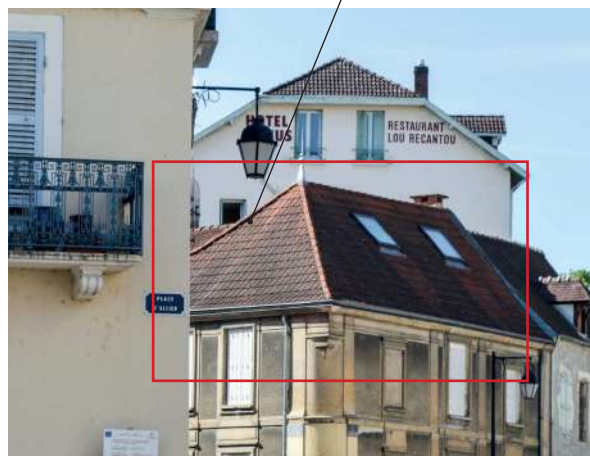
Couverture à 3 pans en tuiles mécaniques
