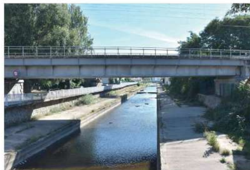
Vue vers l'Est depuis cette même passerelle Pont de la voie ferrée puis territoire communal de Cusset
