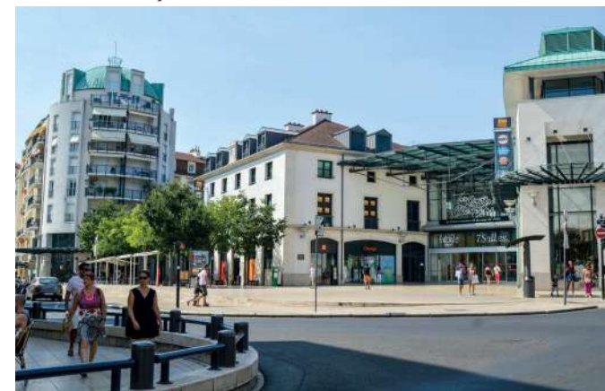
3- Centre commercial des Quatre Chemins - 2002
