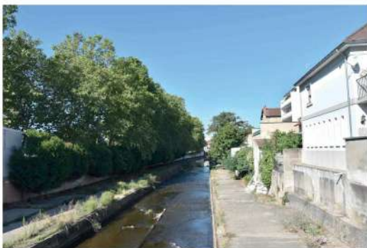
Vue depuis la passerelle reliant la rue Demonet et la rue de Venise au boulevard Albert 1er, vue vers l'Ouest
