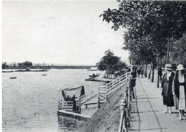
Les quais de l'Allier
