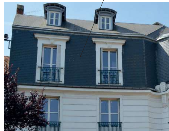
Combles brisés à la Mansart en ardoises
