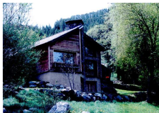
Intégration de bâti contemporain dans le bâti existant
