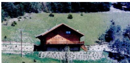
Exemple de terrassement disgracieux
