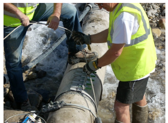
Réparation de fuite
