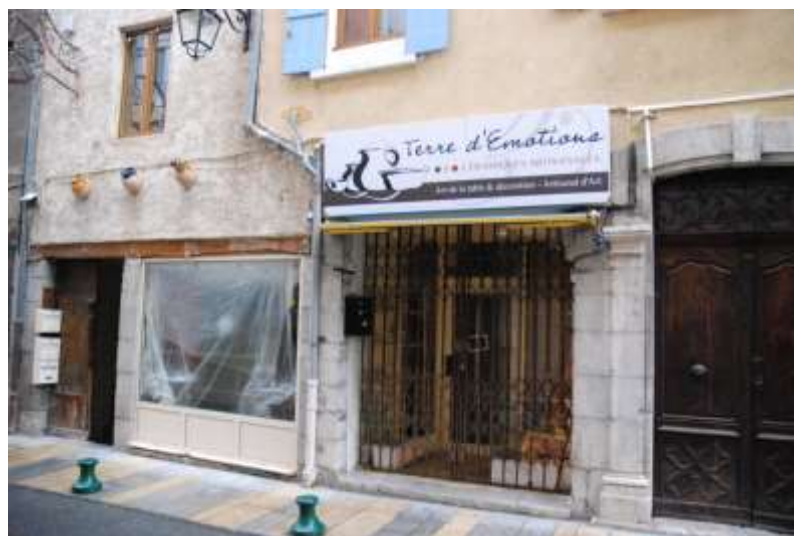
Caisson du volet roulant intégré dans la devanture en applique.
