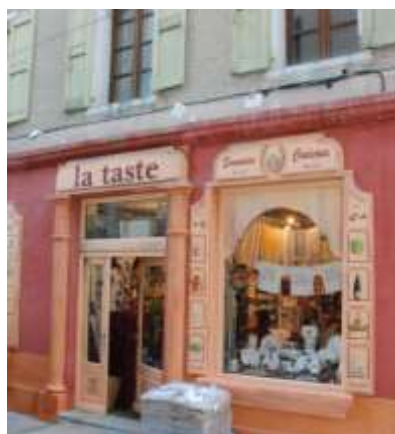
Enseigne intégrée dans la ligne générale des trumeaux, linteaux et bandeaux filants
