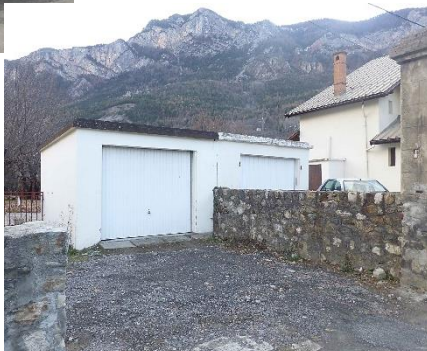
Garages mitoyens, jumelés, en retrait de la voie avec toit terrasse (constructions ultérieures ?)
