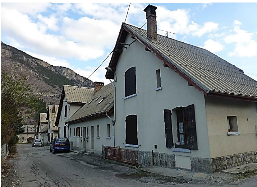
Façade nord, sur rue de la Boucle des Ardoisières
