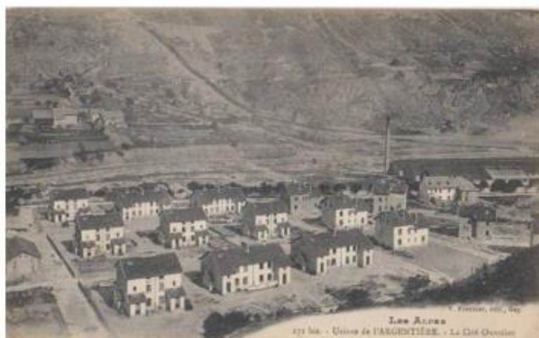
Représentation de la « Cité Ouvrière » en construction
