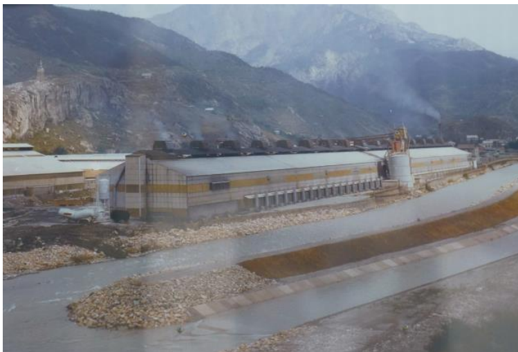
Vue Est de l'usine Pechiney (années 1970) et du canal de fuite EDF
