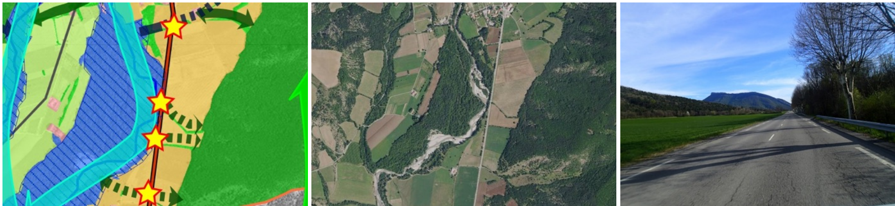
Vues sur le croisement entre les corridors écologiques (haies arborées et boisements) et de la route nationale n°75 : secteur d'affaiblissement des continuités écologiques locales, risque de collision et d'écrasement de la faune sauvage. La photographie du milieu est extraite de la base de données de Géoportail ©
