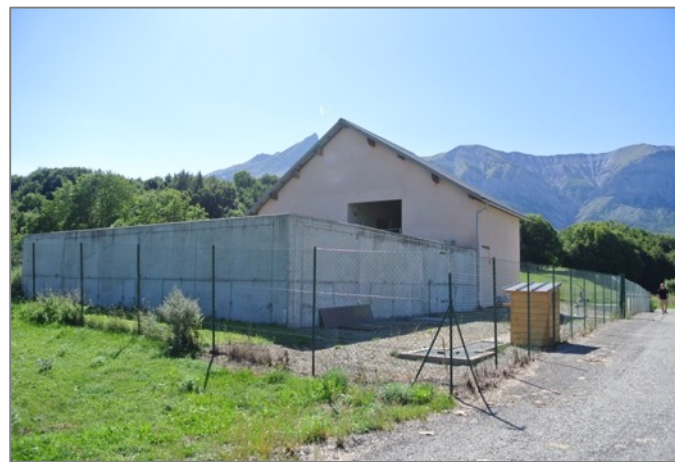
la station d'épuration de Laye
