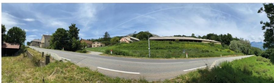
Vue depuis la RN85 sur le STEACL Ab, avec notamment la vue sur l'accès au STECAL via le chemin d'exploitation existant
