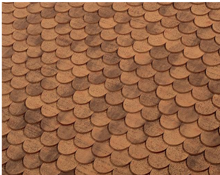
Couverture en tuile écaille traditionnelle
