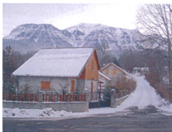
(2) Constructions en cours
