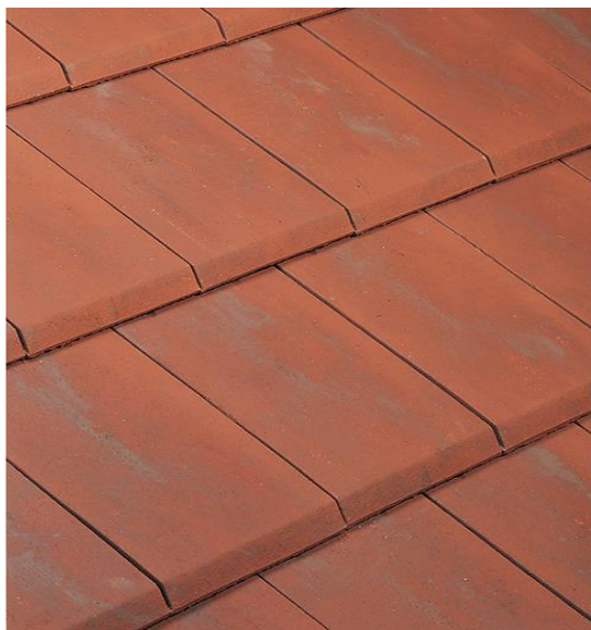
Couverture en tuile plate Alpha 10 - Ste Foy (Iméry's Toitures)
