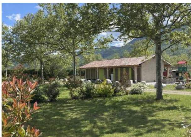
Blocs sanitaires après travaux
