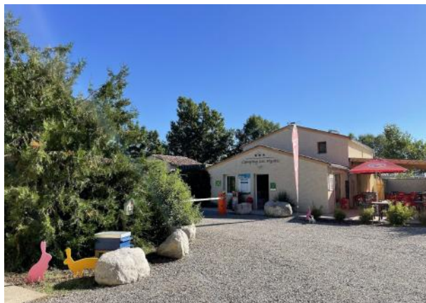
Locaux d'accueil après travaux
