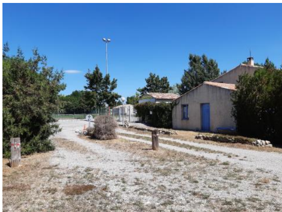
Locaux d'accueil avant travaux
