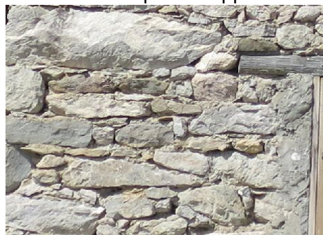
Enduit à "pierre-vue"
