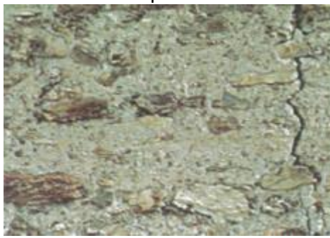
Enduit taloché, lissé et badigeonné
