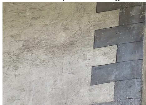
Enduit taloché, lissé et badigeonné
