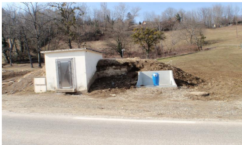
Aménagement de réservoirs artificiels
