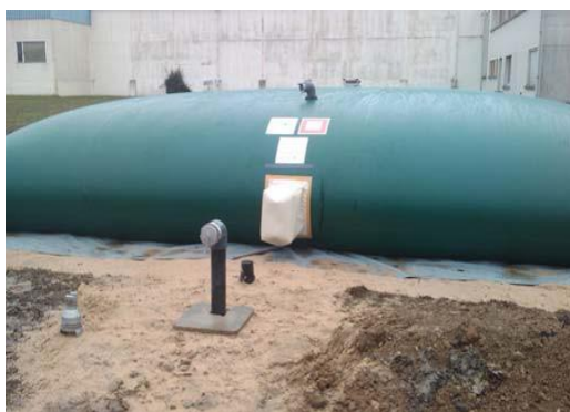
Réserve d'eau souple de 120 m 3 utilisable par le biais d'un poteau d'aspiration
