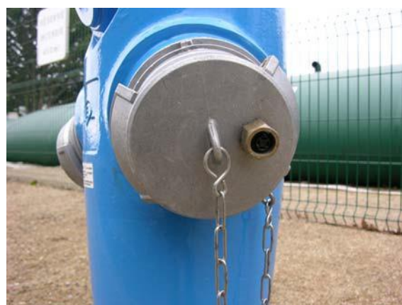
Poteau d'aspiration de 150 mm muni d'un Airclap
