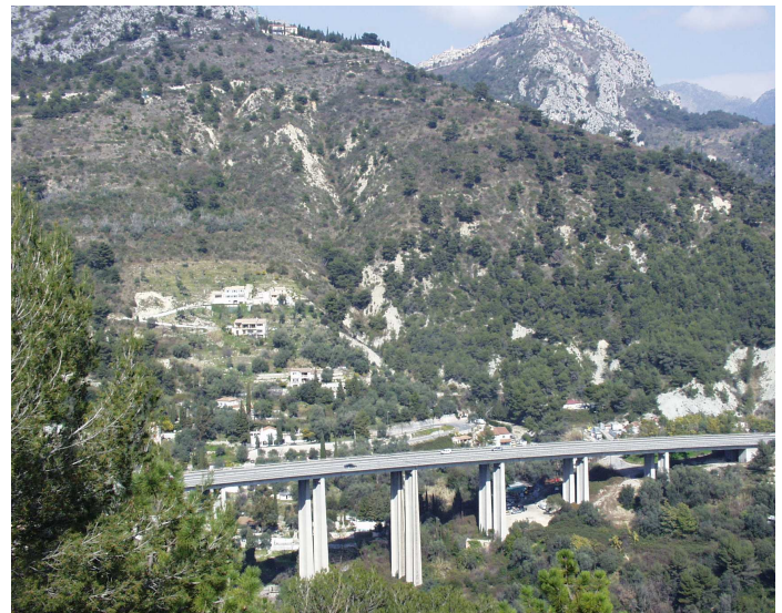
Vue générale du quartier de la Vignasse
