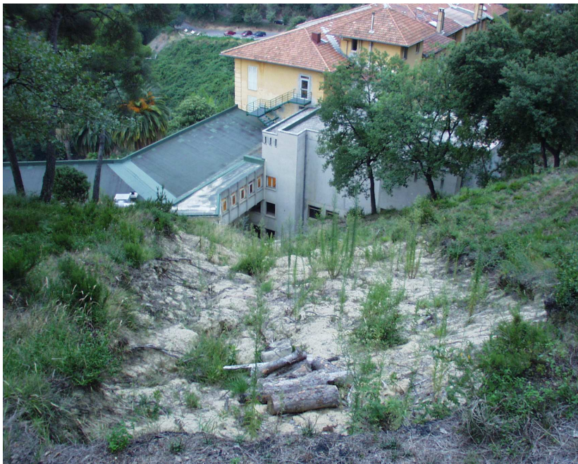
Glissement de terrain directement en amont du Sanatorium
