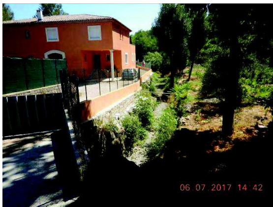
Vallon Saint Antoine à proximité d'une habitation
