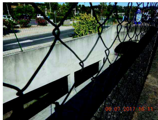
Ouvrage galerie sous le Riou Blanquet
