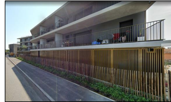
Exemple de bâtiment situé en zone UB, comportant des logements au rez-de-chaussée et qui a été partiellement implanté à l'alignement, obérant la qualité de vie dans les logements au rez-de-chaussée - Chemin des Gourettes – parcelle AZ 495
