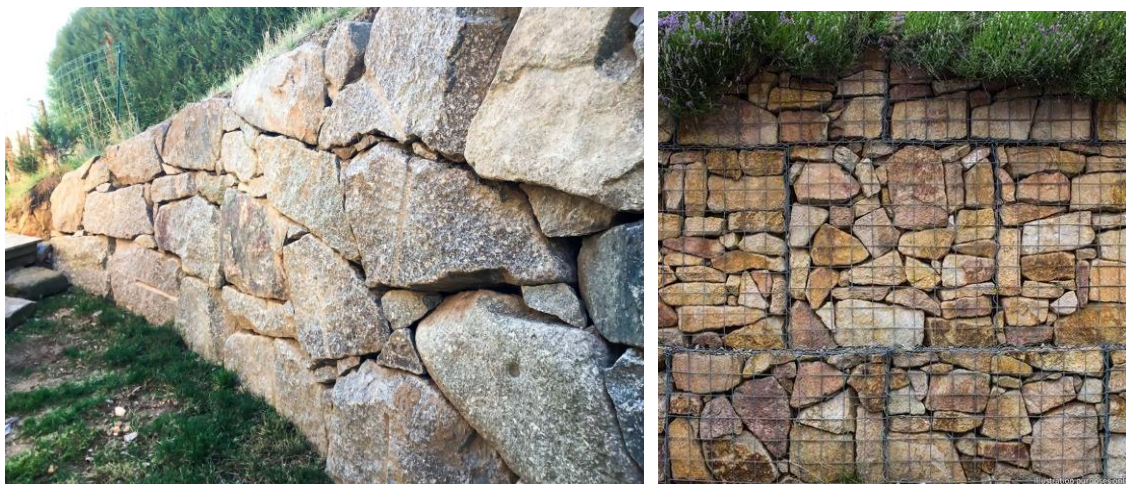
Exemples d'enrochements et de gabions autorisés
