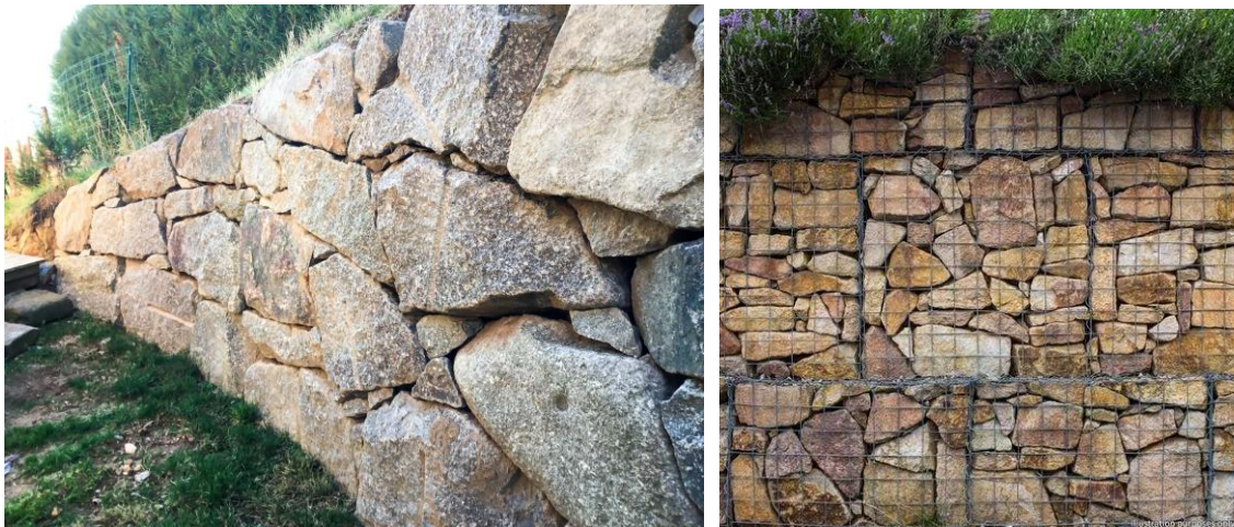
Exemples d'enrochements et de gabions autorisés
