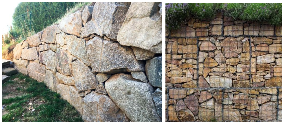
Exemples d'enrochements et de gabions autorisés
