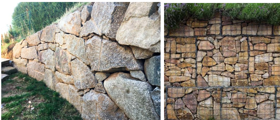
Exemples d'enrochements et de gabions autorisés
