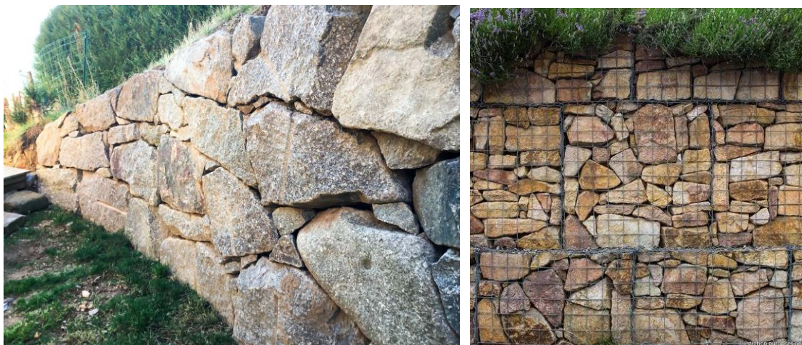
Exemples d'enrochements et de gabions autorisés
