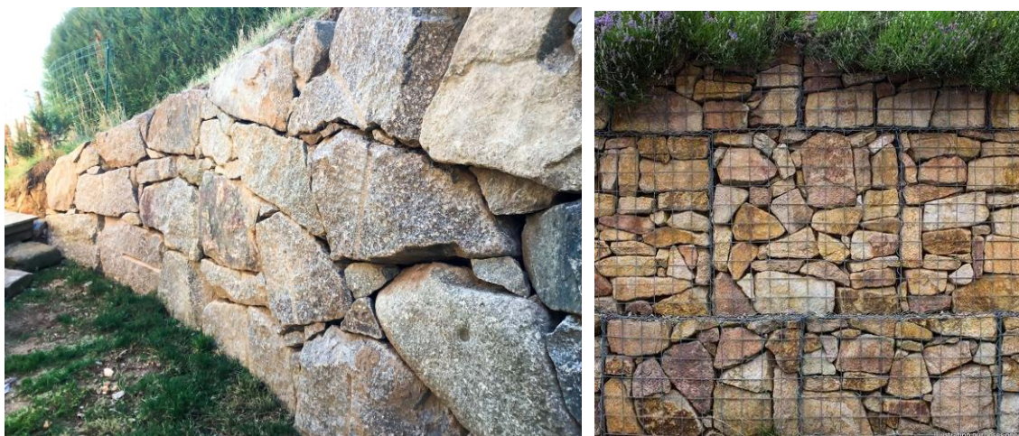
Exemples d'enrochements et de gabions autorisés
