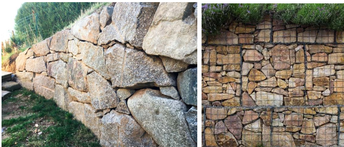
Exemples d'enrochements et de gabions autorisés
