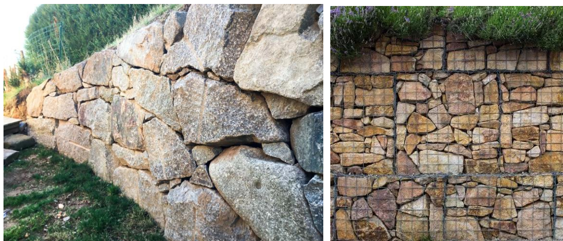
Exemples d'enrochements et de gabions autorisés
