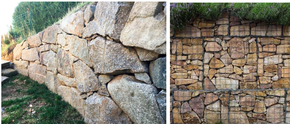
Exemples d'enrochements et de gabions autorisés
