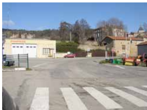
RD 234 « carrefour des pompiers »
