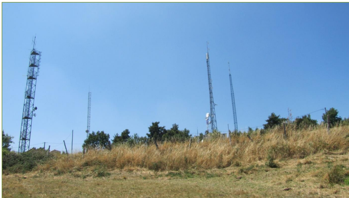
Photographie 24 : Site des antennes (source : Eco-Stratégie, le 16 juillet 2015)
