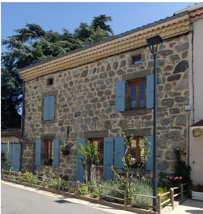
Photographies 81 –Eléments bâtis du centre-bourg actuel (Source : ECO-STRATEGIE le 16 juillet 2015)
