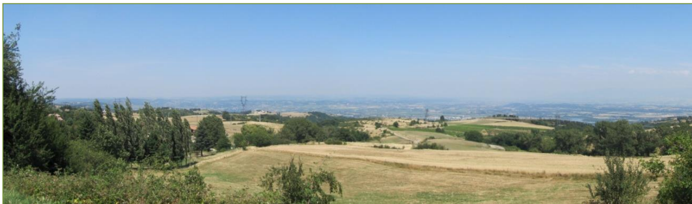
Photographie 26 : Ligne électrique barrant le panorama en direction de la vallée du Rhône depuis le chemin des Combes (source : Eco-Stratégie, le 16 juillet 2015)
