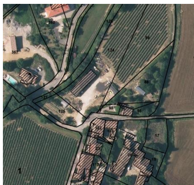
Lieu-dit « La Rouvière Est » : hameau partiellement détruit
