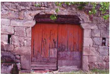
Portail de grange. Le linteau droit en bois permet de franchir de plus grandes portées.
