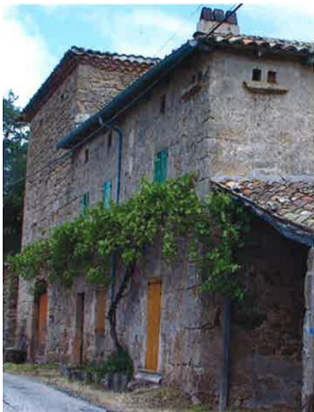
Construction traditionnelle avec pierres jointées à la chaux.
