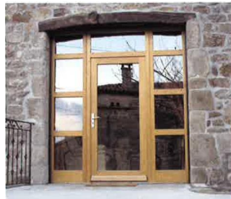
Porte de grange transformée en baie vitrée.
