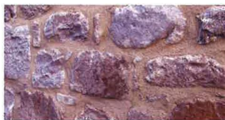
Enduit de jointoiment à la chaux.
