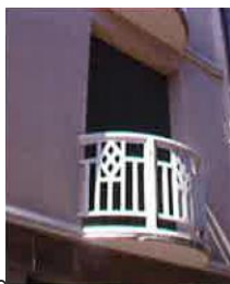
Vernoux-en-Vivaraïs, balcon en béton.
