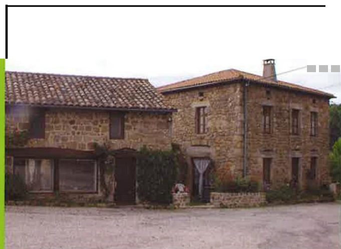
Silhac, toitures à deux et quatre pentes.
