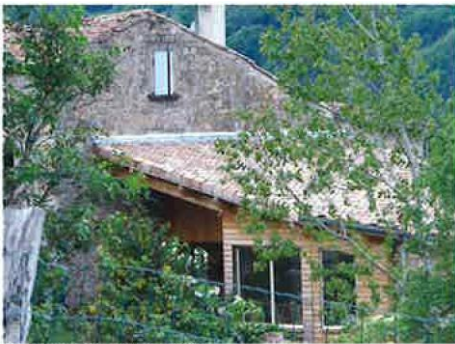
Saint-Aspère, extension en bois d'un bâtiment ancien.
