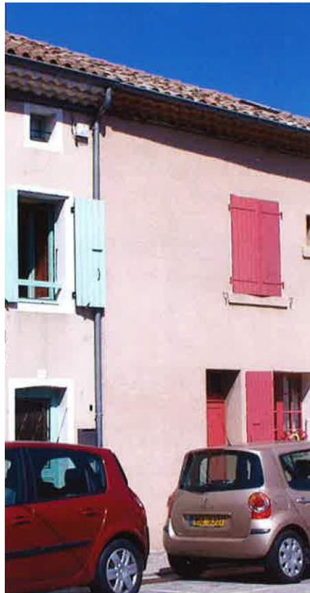
Vernoux-en-Vivaraiz, utilisation de tons neutres pour la façade et de la couleur pour les volets.
