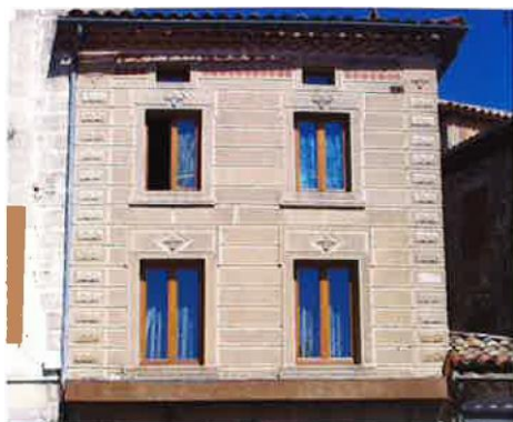
Vernoux-en-Vivarais, technique cimentière de fausses pierres décorées pour donner un aspect noble à l'édifice.
