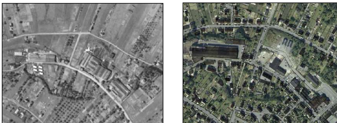
Fonderie Béroudiaux et bâtiments d'activités en 1949 et 2015 – source : Géoportail
