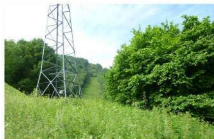
Couloir entretenu sous la ligne électrique
