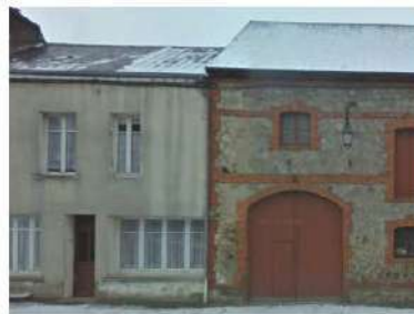
Rue Gabriel Brichet (Hargnies), percée de baies horizontales peu harmonieuses et peu intégrées au contexte architectural.
