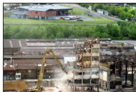
Démolition de la tour Porcher Source : www.lunion.com
