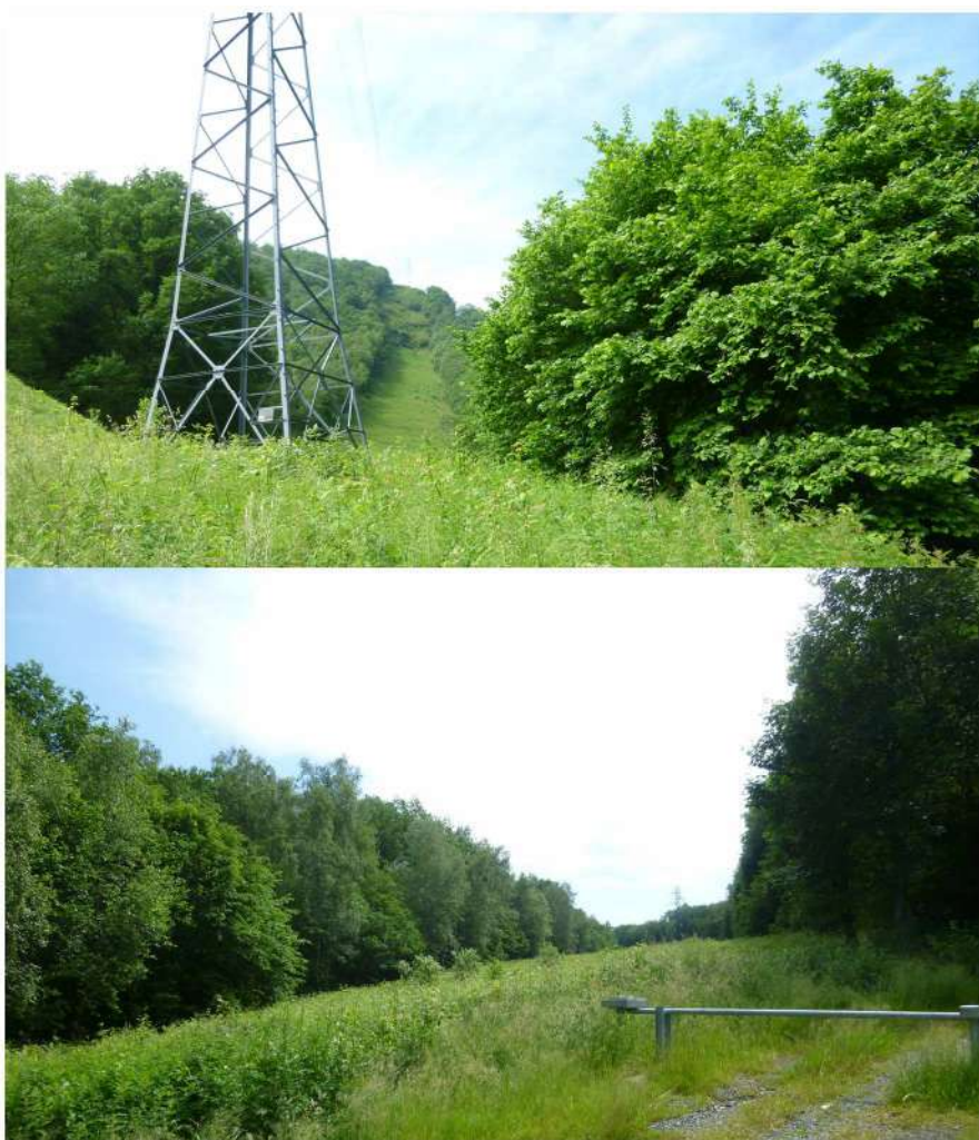
Couloir entretenu sous la ligne électrique
